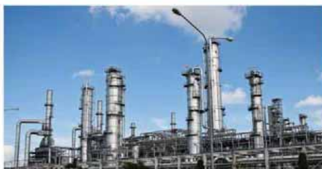
Ирак Salah - Электростанция Aldeeen 2X630MW
